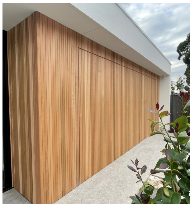
Flush Mount Timber Clad Tilt Door
